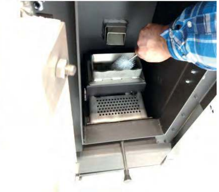
CZYSZCZENIE KOMORY piecyka (szczotka nie jest dołączana do piecyka)
