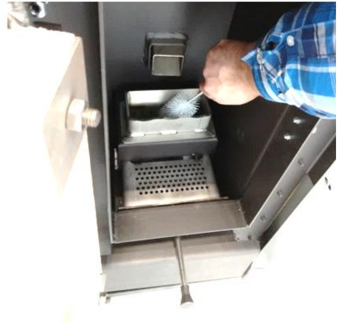
CZYSZCZENIE KOMORY KOTŁA (szczotka nie jest dołączana do kotła)
