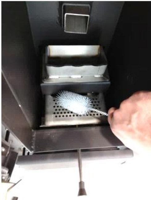
CZYSZCZENIE KOMORY KOTŁA (szczotka nie jest dołączana do kotła)
